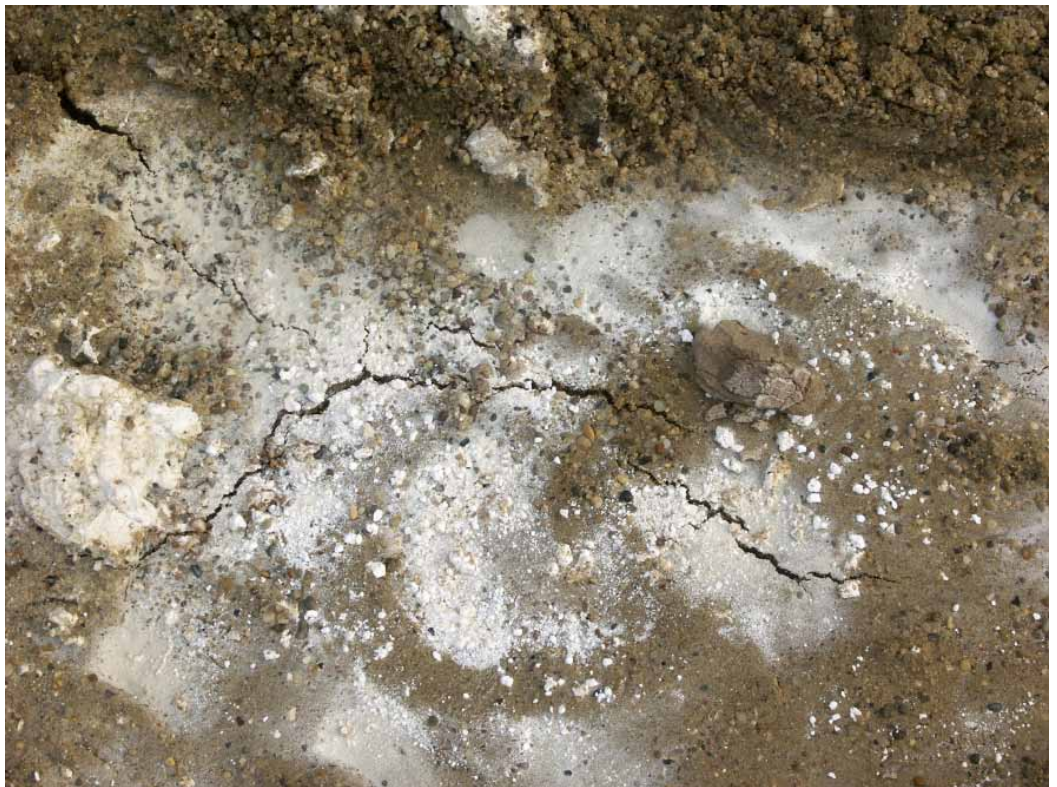
Sogenanntes „Trockenlöschchen“: die direkte Verarbeitung des Branntkalkes mit Sand
