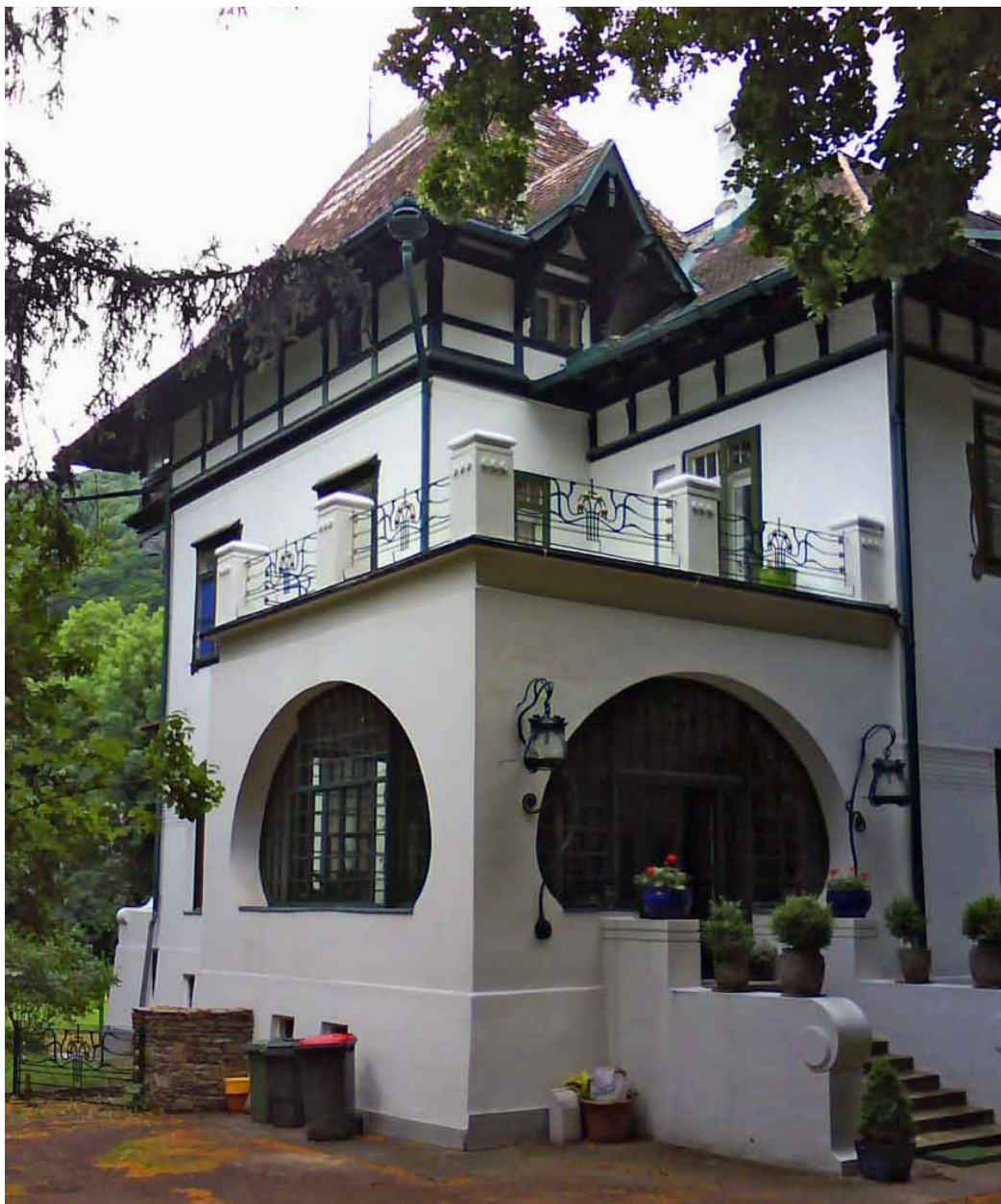
Hinterbrühl, Olbrich-Villa, sorgfältig instandgesetzt und gepflegt
