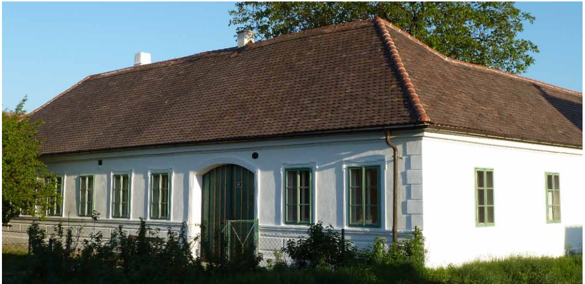
Ansicht Nord-West, nach Renovierung (2011)
