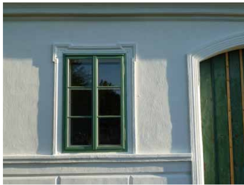
Ansicht Nord-West, nach Renovierung, Details (2011)
