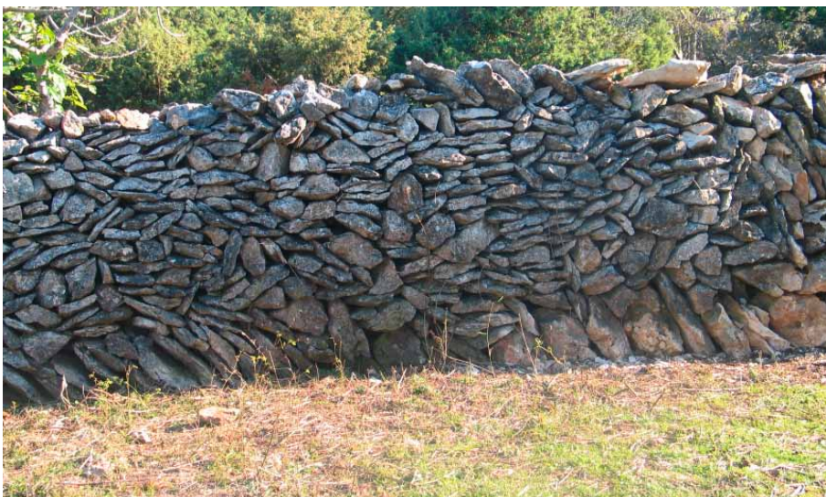
Trockenmauern aus Steinschichtungen dienen als Begrenzungen von Gärten und Weideland.
