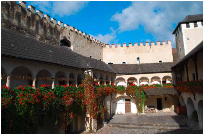
Weissenkirchen, Teisenhoferhof, Einblick in den Hof nach Norden
