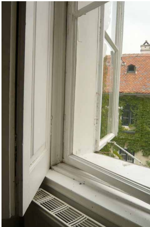
Hollenburg, Geymüllerschloss, Fensterdetail
