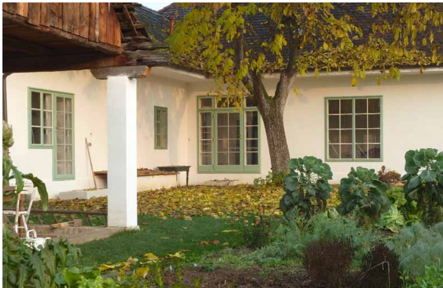
Ansicht Süd, nach Renovierung/Umbau
