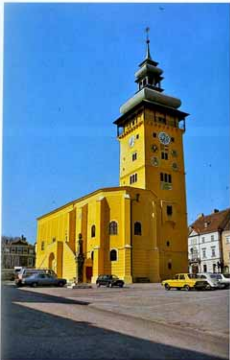
Retz, Marienkapelle und Altes Rathaus. Die später zum Retzer Rathaus adaptierte gotische Marienkirche wurde in den letzten Jahren innen und außen umfassend restauriert
