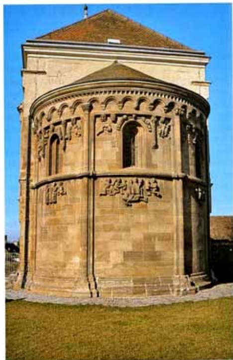
Schöngrabern, Pfarrkirche, Apsis. In den letzten Jahren wurde als Pilotprojekt die Konservierung der Apsis und von Teilen der Süd- und Nordfront durchgeführt, wobei das besondere Problem in der Verfestigung des zerfallenden Schleifsteines bestand
