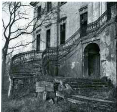
Ladendorf. Die einst besonders prachtvolle barocke Schloßanlage konnte bisher nur notdürftig abgesichert werden und harret weiter einer neuen Verwendung.
