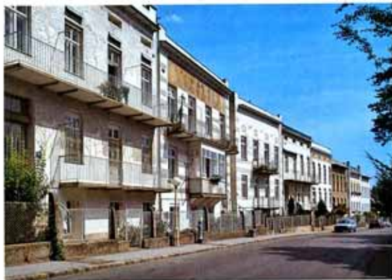
Brunn a. Geb., Reihenhausanlage von Architekt S. Hubatsch, Restaurierung im Rahmen der Fassadenaktion
