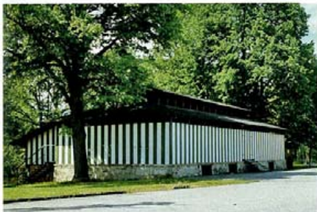
In Schönberg wurde ein neues Bad errichtet. Das alte Bad ist heute ein Veranstaltungsraum.
