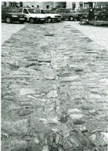
Die freigelegten Entwässerungsmulden am Hauptplatz in Retz stammen vermutlich aus der zweiten Hälfte des 16. Jahrhunderts.
