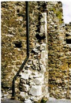
Das gut sichtbare Gußmauerwerk, gegenüber der Nordwestecke der Pfarrkirche, des abge- brochenen Wohntraktes (1250/70)
