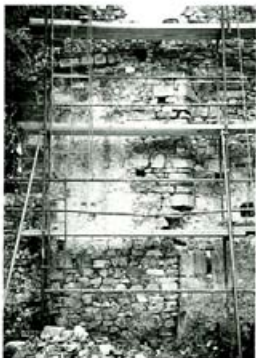
Das erste Tor der Burg in der Nordmauer der Vorburg aus 1170/80. Im Zuge der Verlegung der Burgeinfahrt wurde es 1250/70 zugemauert.
