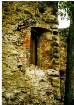
Nördöstliches Mauerwerk der Ostwand der Vorburg. Dieses ist mit einer Kastenbuckel- quaderung versehen (1250/70)
