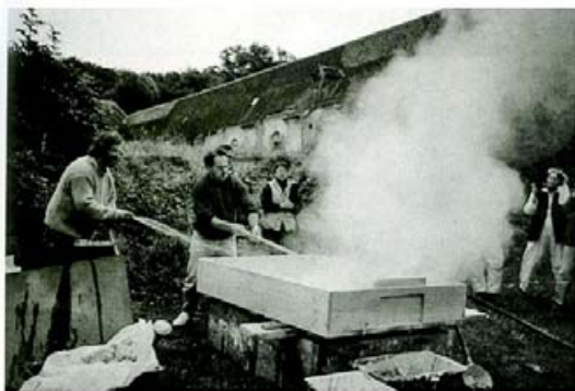
Alte Technologien – Löschkalk auf der Baustelle – aber auch neue Verfahren – wie Konsolidierung von Baukörpern durch vorgespannte Aramidstäbe – werden bei der Erhaltung historischer Bauten z.B. in der Kartause Mauerbach eingesetzt. (ICCROM Kurs 1996)
