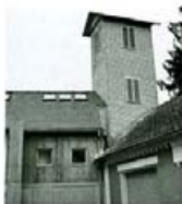
Der ehem. Schlauchturm.
