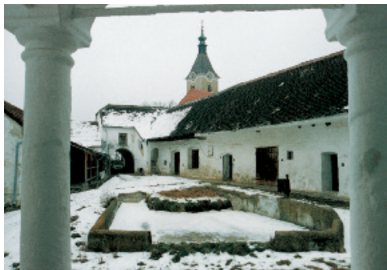
Radlbrunn, Brandlhof, Innenhof
