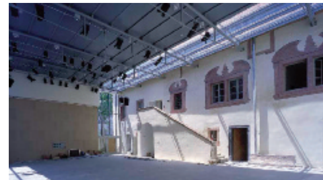
Freistadt, Salzhof, Innenhof Westseite mit Freitreppe nach der Sanierung
