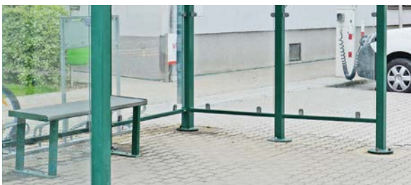
Ein ca. 5–10 cm hoher Spalt an der Unterseite der Seitenwände trägt zur Durchlüftung und Selbstreinigung des Fußbodens bei.
