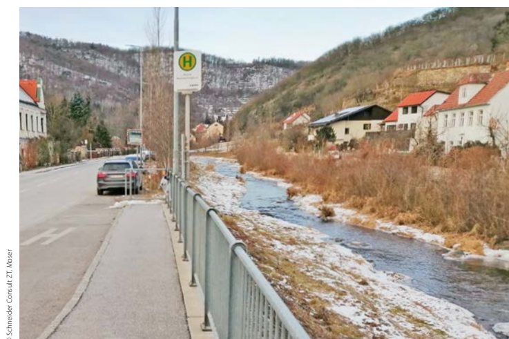
Im Bereich von Böschungen sind Auftrittsfläche und Zugänge mittels Absturzsicherung zu sichern.
