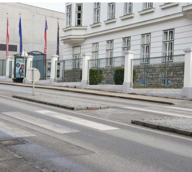
Haltestelle mit Querungshilfe (Mittelinsel) und Schutzweg
