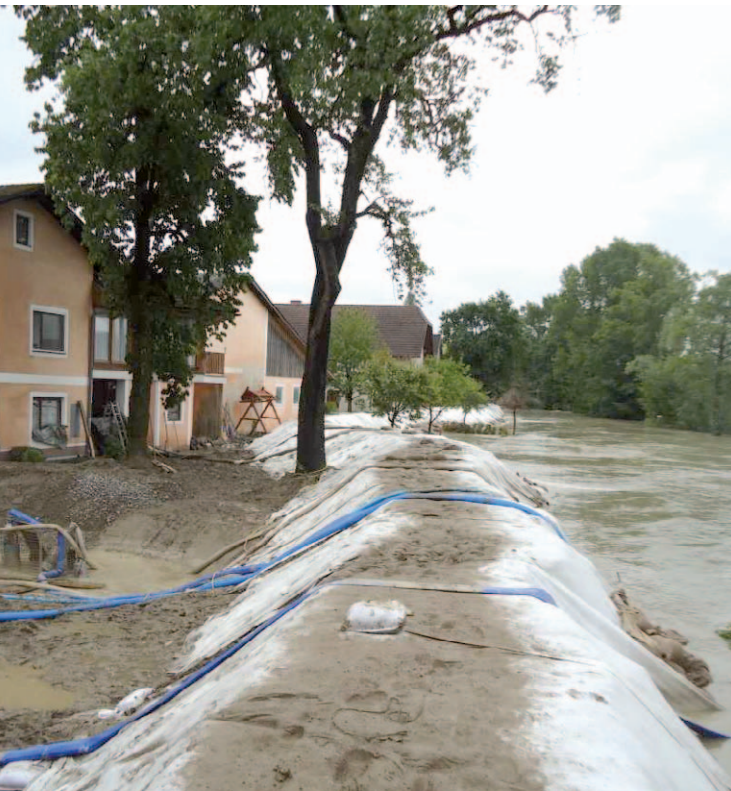
Ein provisorischer Damm konnte in Hagsdorf große Schäden verhindern.
