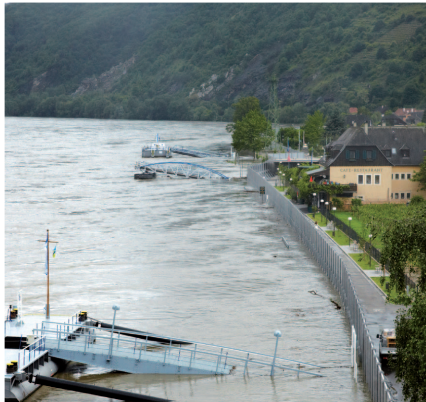
Die Hochwasserschutzanlagen in der Wachau haben keine Auswirkungen auf stromabwärts liegende Orte.
