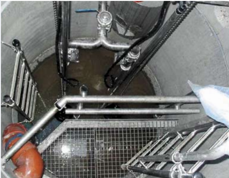
Pumpwerk in Schachtbauweise
